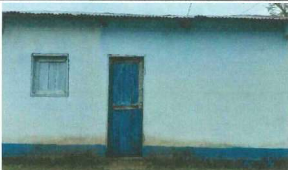
Foto 5: Se observa la necesidad de sustituir y ampliar las ventanas que actualmente cuenta el establecimiento para una mejor circulación de aire
