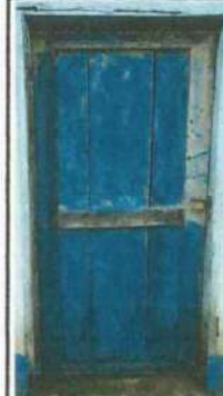
Foto 4: Se observa la necesidad de sustituir la puertaa de madera por metal y abrir una puerta en la parte mas visibles de la entrada
